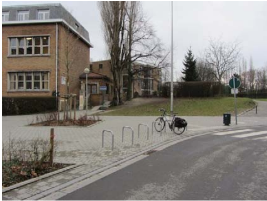
Placement d'arceaux à l'occasion d'une modification du plan de circulation aux abords de l'école Saint-Dominique
