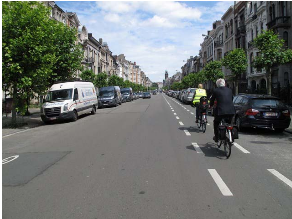
Rue Demolder (PCM dans un sens et BCS dans l'autre)
