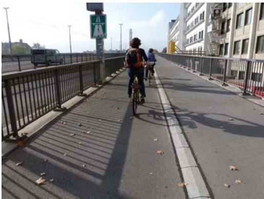
Bordure chanfreinée entre les parties cyclable et piétonne
