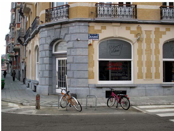
Placement d'arceaux dans le cadre d'un marquage de réduction de la voirie
