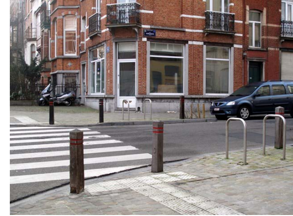
Placement d'arceaux dans le cadre de l'aménagement d'une oreille de trottoir
