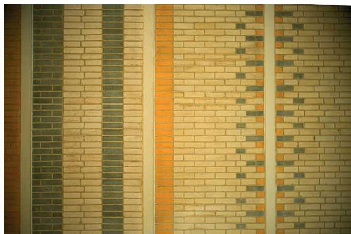
👉 Plafond de la salle de conférence | Plafond van de vergaderruimte
