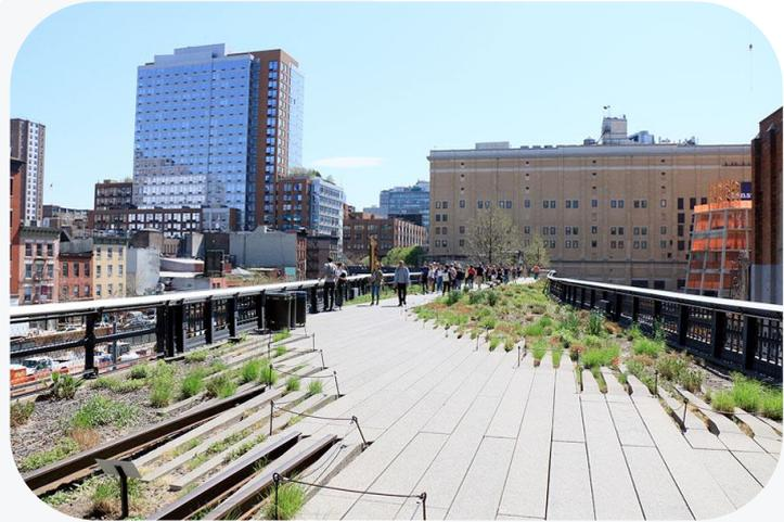
Type de pavement avec joints interstitiels intégrés – High Line New York
