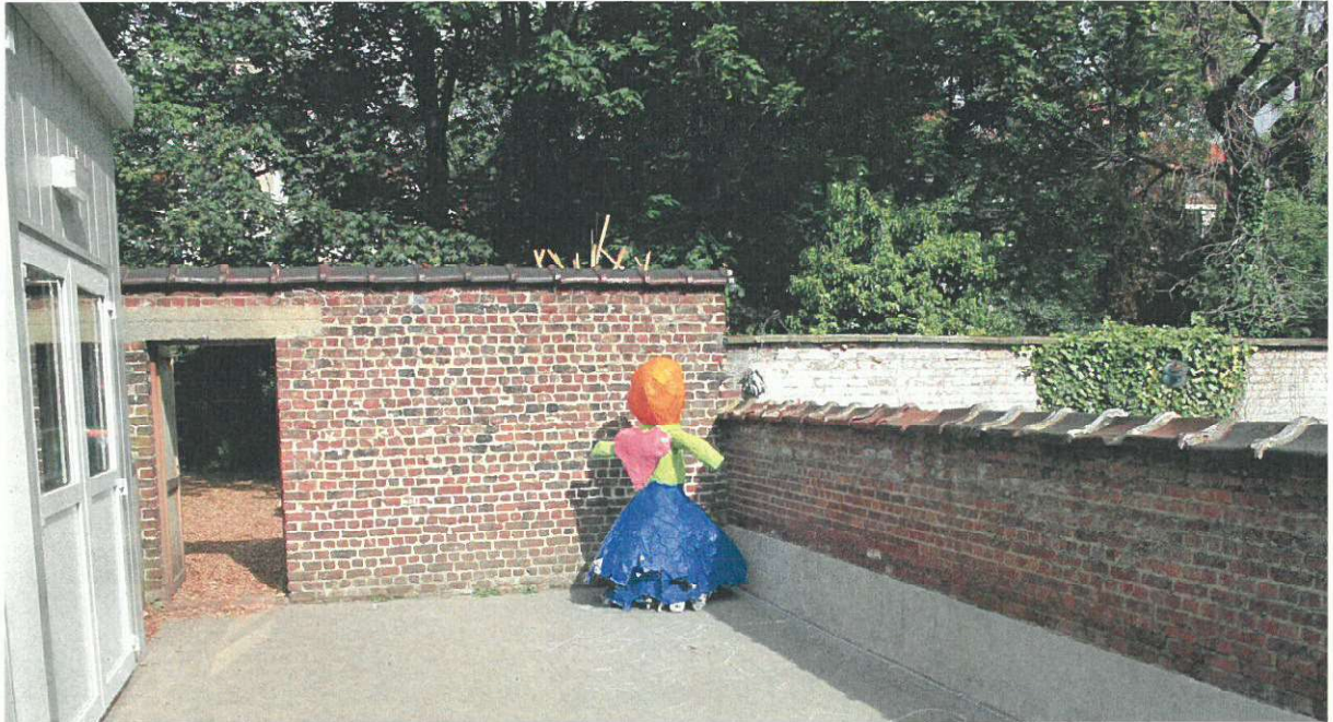
foto 1 : de bestaande tuinmuur en doorgang tussen de huidige containerklassen en het binnenterrein
