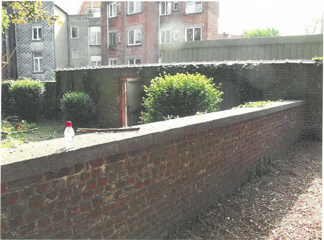
foto 2 : de af te breken lage muur tussen tuin Muziekacademie en het binnenterrein
