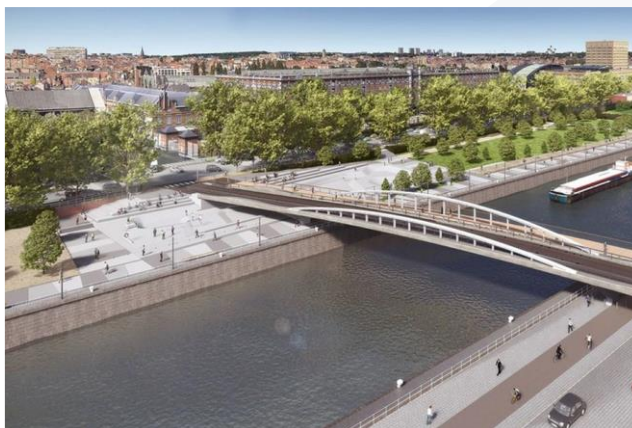
Figure 29 - Pont cyclo-piéton et bus/tram « Suzan Daniel » (Beliris/PU 2016 - début des travaux sept 2019)
