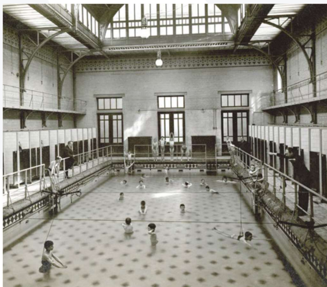
Ancien bassin de natation (école n°1)
