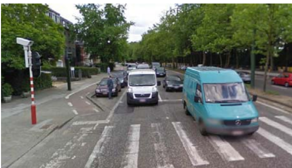
Lambermontlaan: Vrijliggend fietspad met laatijdig invoegen aan kruispunt, in de dode hoek van aanschuivende auto's die rechts afslaan)
